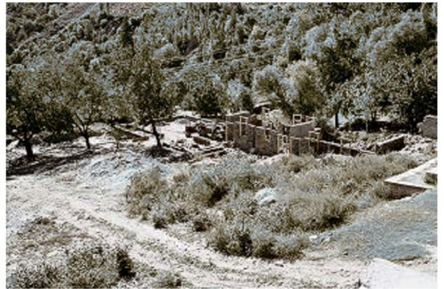
Bauboom bei der Mädchenschule
